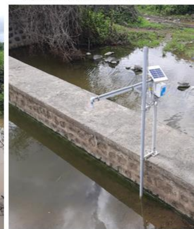
(d) Direct mounting (regular + ultrasonic)
